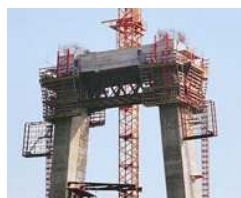
önjáró kúszó zsaluzat Nem szükséges daru!
