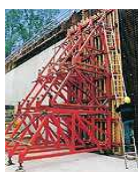
kétoldali \leftrightarrow egyoldali zsaluzat
