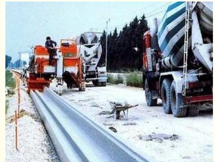
Kerb (curb) construction by concrete finisher Szegély építése finisherrel
