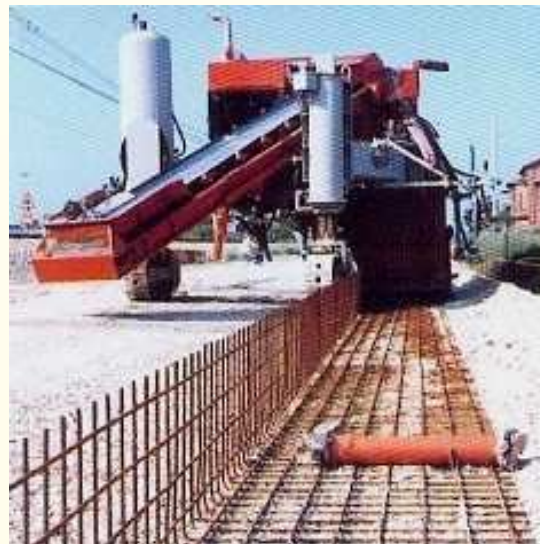
Kerb (curb) construction by concrete finisher Szegély építése finisherrel
