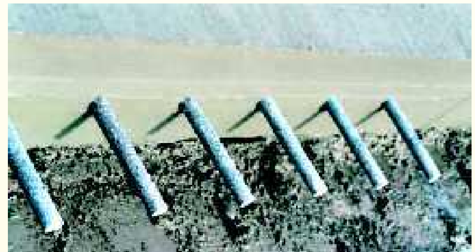
Transversal joint-bars inserted (between parallel lanes) Keresztirányú vasalás (párhuzamos forgalmi sávok közé)
