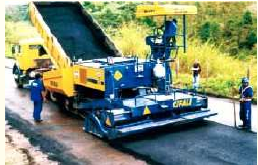
Asphalt finisher in action Aszfalt-terítő munka közben
