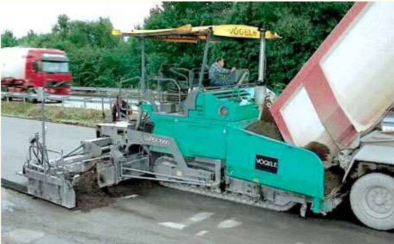
Feeding the finisher Finisher „etetése”
