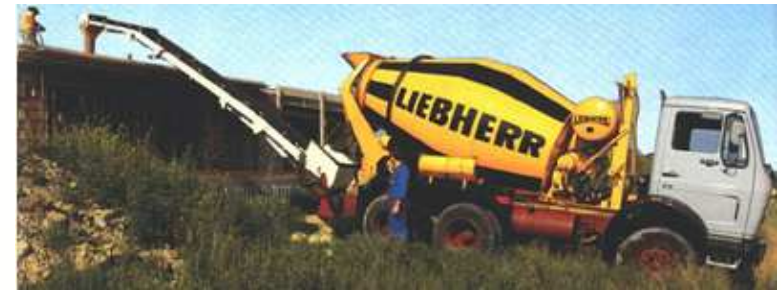
Mixer truck with delivery conveyor (in action) Feladószalagos mixerkocsi (munka közben)
