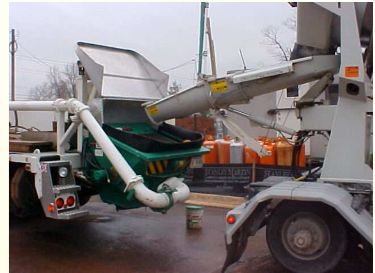
Mixer feeding the pump Betonpumpa „etetése” mixerből
