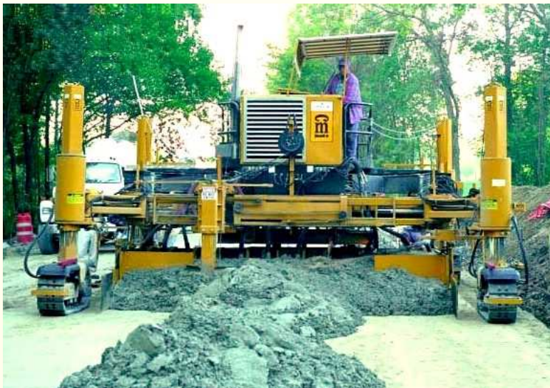
Course spreading Alaprég terítése
