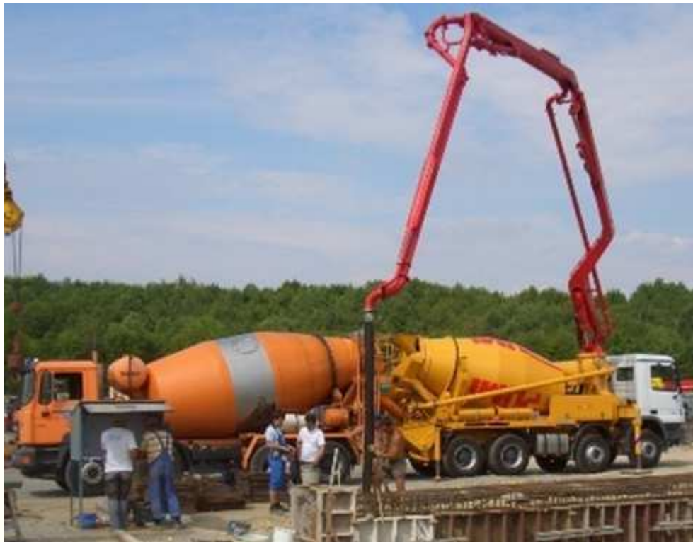
Mixer truck and "pumix" co-operating at the site Mixerkocsi és pumix ko-operációja az építési helyszínen
