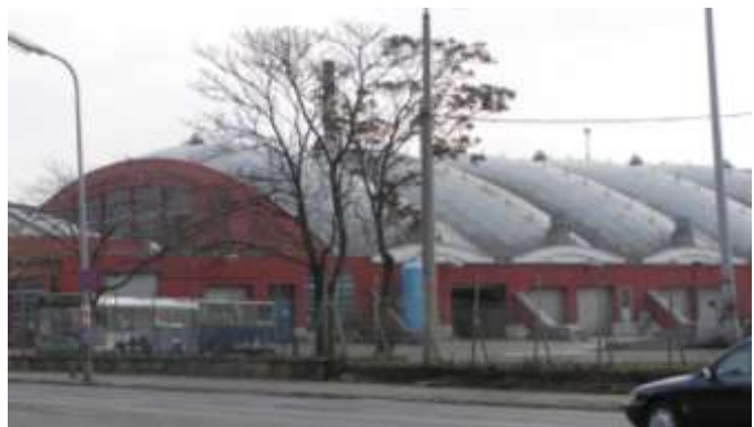
4. ábra – A Hamzsabégyi úti buszgarázs (Bp. 2004), ami 1941-ben a legnagyobb fesztávú héjszerkezetű csarnok volt.
