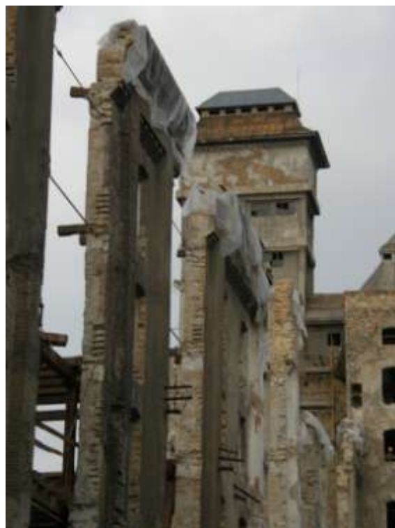
58. ábra – Gizella malom a tartószerkezet bontása közben (Bp., 2007)
