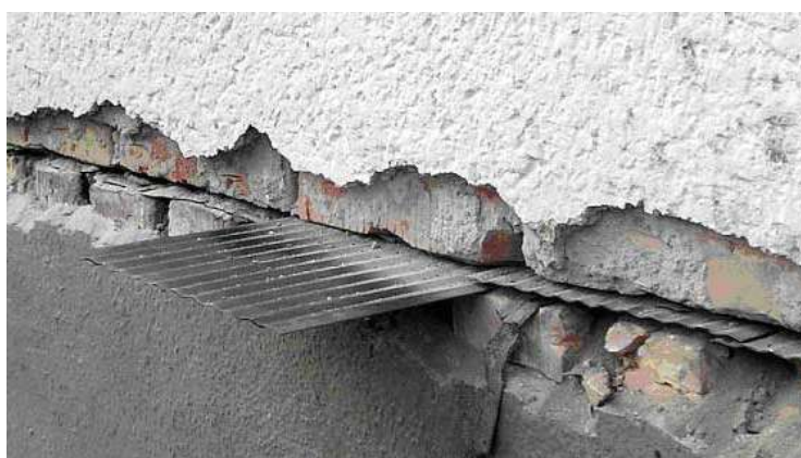
45. ábra – Utólagos falszigetelés fémllemezrel ( www.izometal.hu/muszaki.htm 2009.01.27.)
