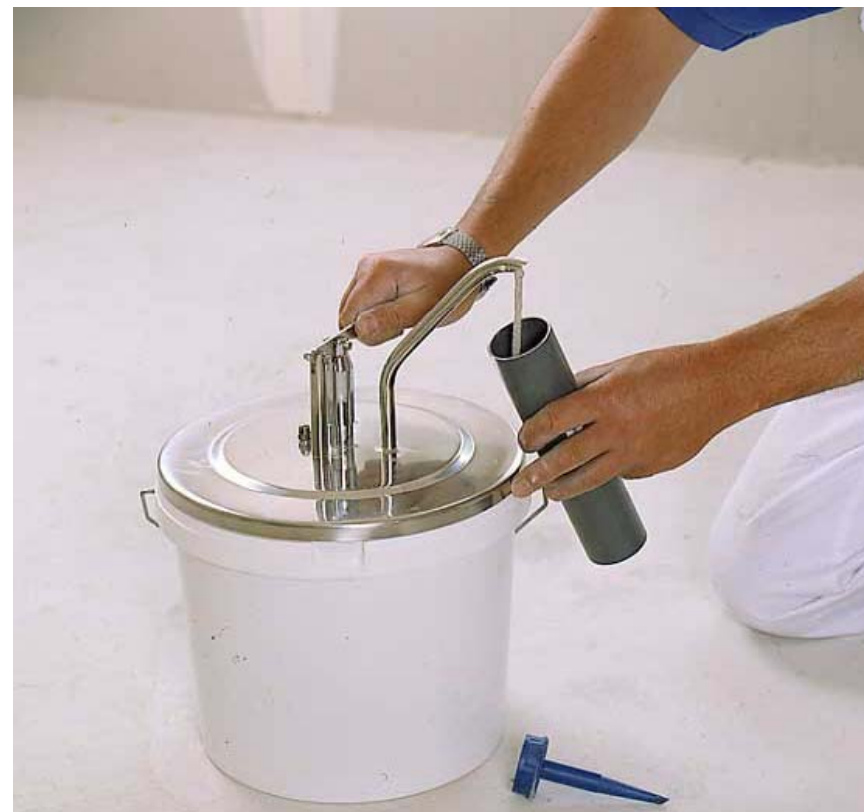
A hézag kitöltése kinyomópisztollyal
