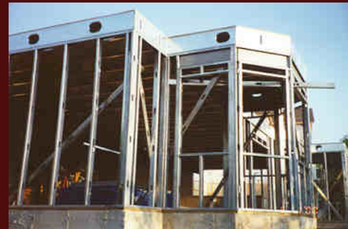
4. ábra Támfalra épített könnyűszerkezetes raktár. Készítette: STRUKTÚRA-BAU-TYP Kft.
