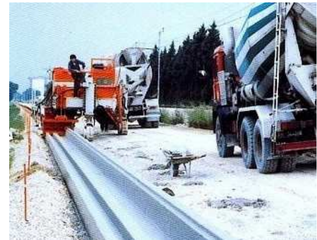
Útpálya szegély készítése betonfiniszerrel
