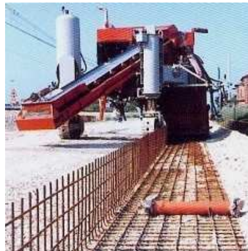
Útpálya szegély készítése betonfiniszerrel
