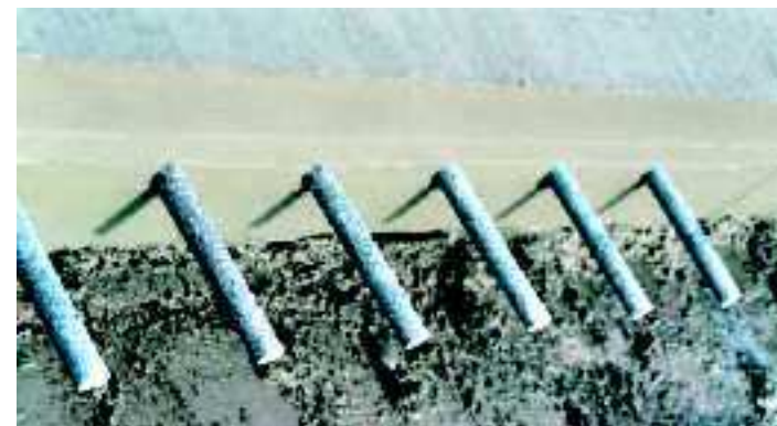
Több sávban épített burkolat keresztirányú hézagbetétei
